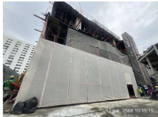
รูปที่ 18 ตาข่ายกันฝุ่น (Mesh Sheet) ชนิดป้องกันไฟลาม
