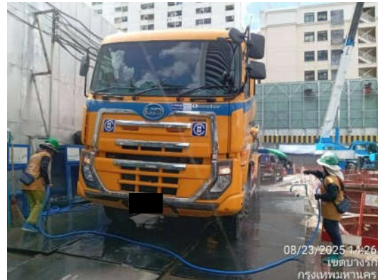
รูปที่ 12 ล้างล้อรถบรรทุก
